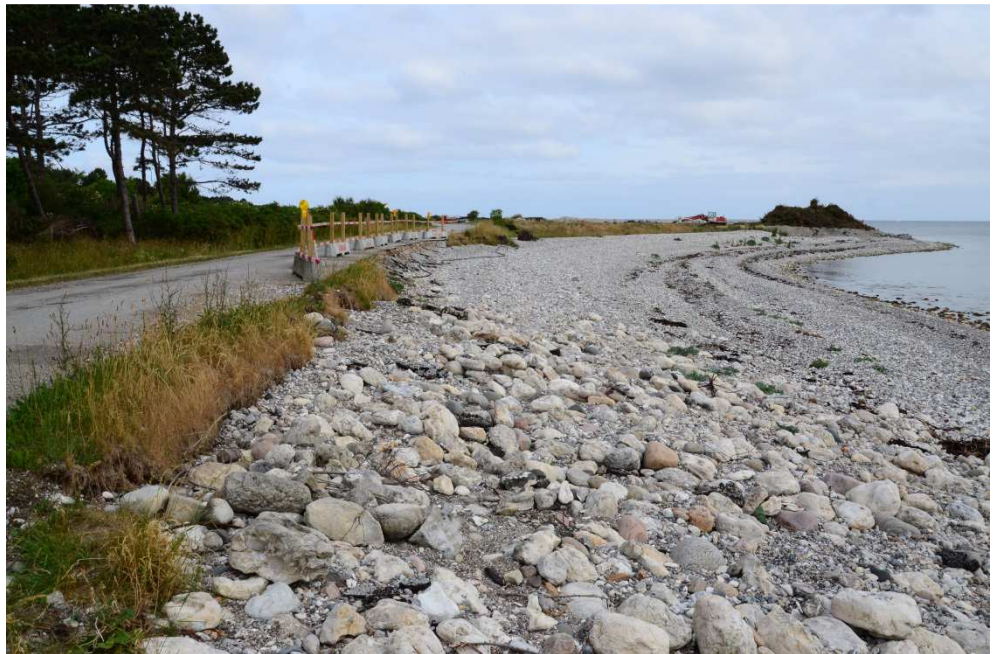
Figur 2-6 Erosion af vejen syd for Klint Havn set mod nord mod havnen
