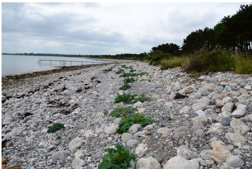
Figur 2-7 Naturlig stenstrand syd for strækning, hvor Klint Havnevej er undermineret
