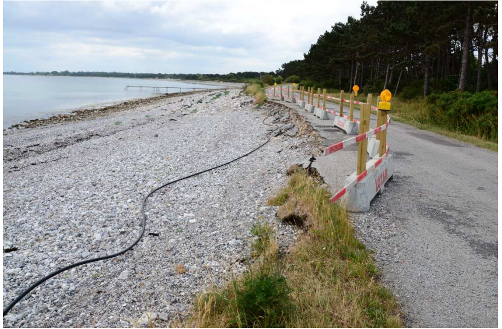
Figur 2-5 Erosion af vejen syd for Klint Havn set mod syd
