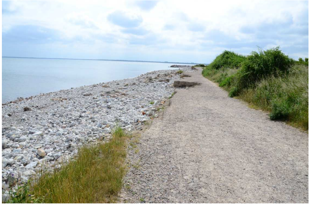
Figur 2-12 Stenstrand og eroderet vej nord for Klint Havn nord for Østergårdsvej, set mod syd
