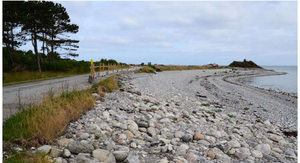
Figur 6-3 Erosion af vejen syd for Klint Havn set mod nord mod havnen
