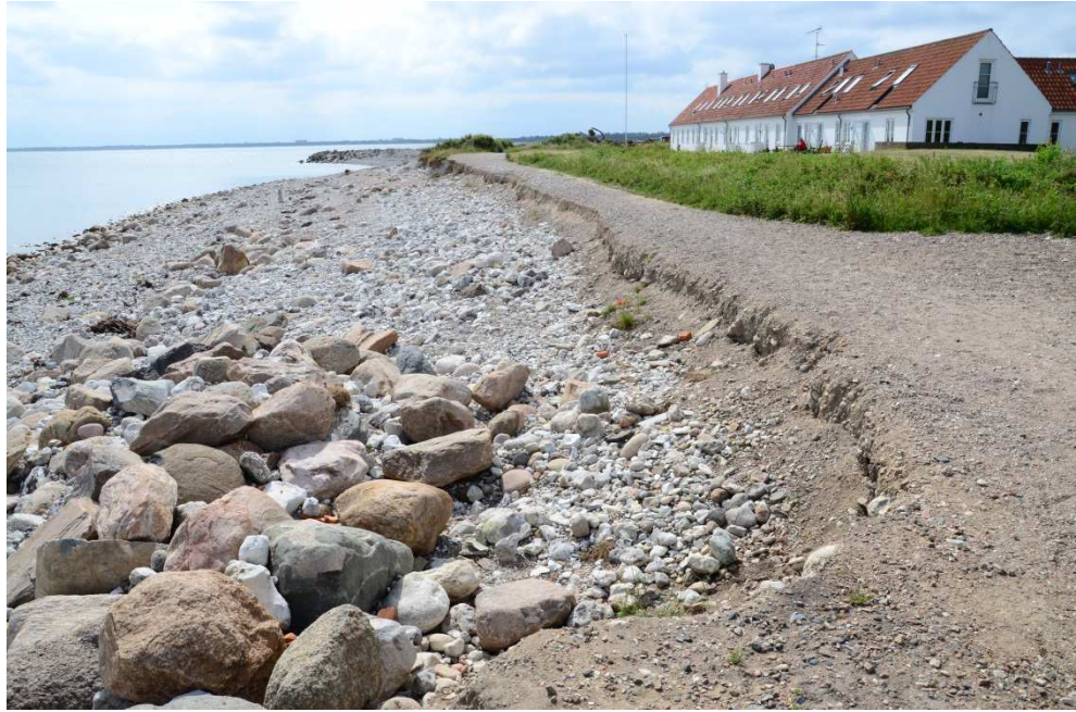
Figur 2-10 Stenstrand og eroderet vej nord for Klint Havn
