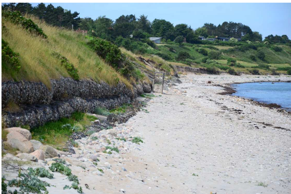
Figur 2-18 Gabion-mur ved Nordre Strandvej
