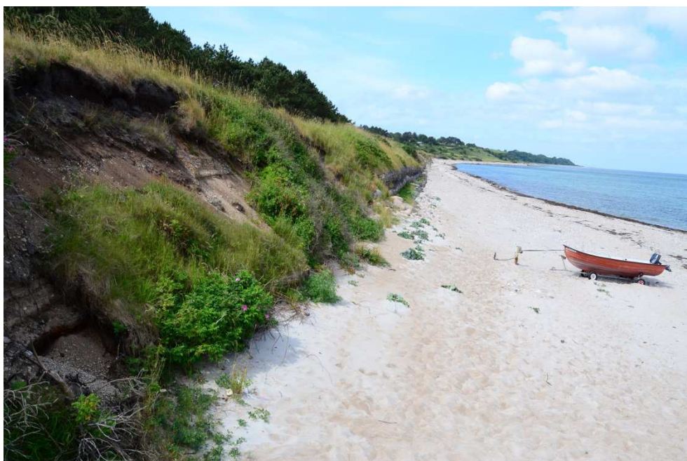
Figur 2-17 Erosion øst for gabion-mur ved Nordre Strandvej
