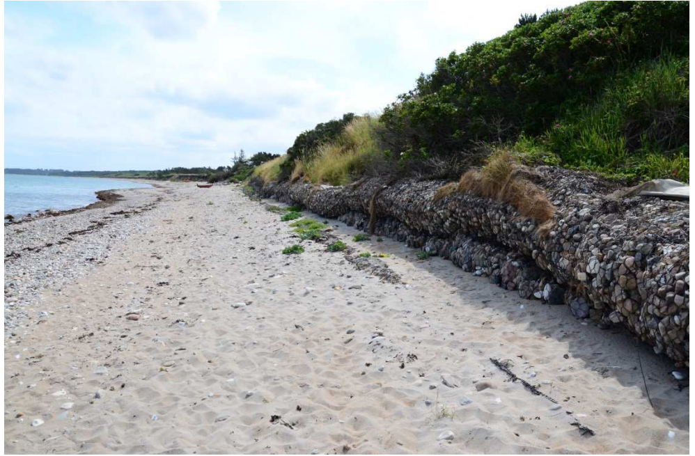
Figur 2-19 Gabion-mur ved Nordre Strandvej ved Lumsås
